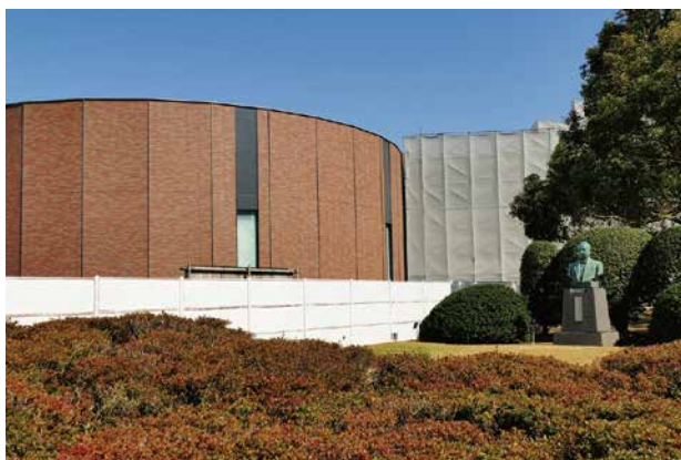
佐吉翁像が見守る中、中央棟の建設が順調に進む
